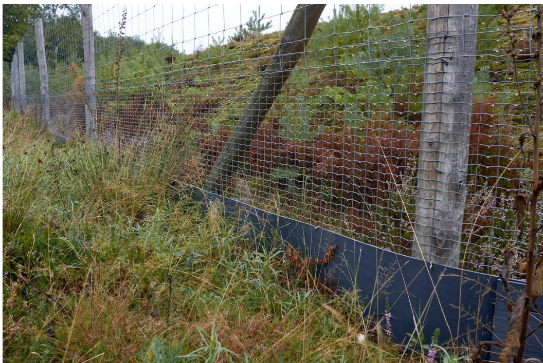
Joonis 58. Näide ulukitarast Hollandis, mille ülemine pool on suurema võrgusilmaga ja allosa tihedama võrguga, et takistada väiksemaid loomi. Allserva on lisatud UV-kindlast plastist riba kahepaiksete ja roomajate tõkestamiseks. Ebapiisava hoolduse tõttu on kahepaiksetel võimalik ronida mööda taimi üle tõkke. Foto Jaanus Remm.
