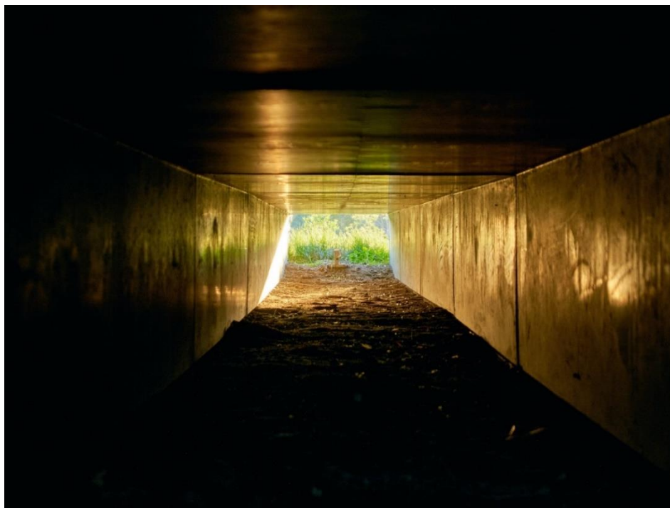
Joonis 71. Kandilise betoonist konnatunneli sisevaade. Põhi on avatud ja kaetud loodusliku pinnasega. Foto Jaanus Remm.
