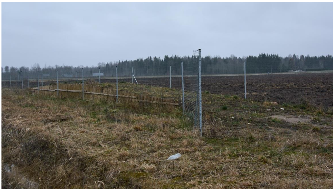
Joonis 61. Tagasihüppekoht Tallinn-Tartu maanteel, millel on suunavad aiad ja keskel auk. Sarnast lahendust on kasutatud ka RB põhiprojektis. Foto Jaanus Remm.
