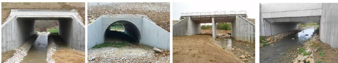
Joonis 2. Truupid, mis on kohandatud ka loomade läbipääsuks 29
