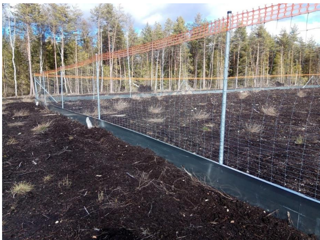
Joonis 22. Näide kahepaikseid suunavast läbipaistmatust tõkkest. Aia ülaseras olev oranž plastriba muudab aia lindudele ja imetajatele paremini nähtavaks.
