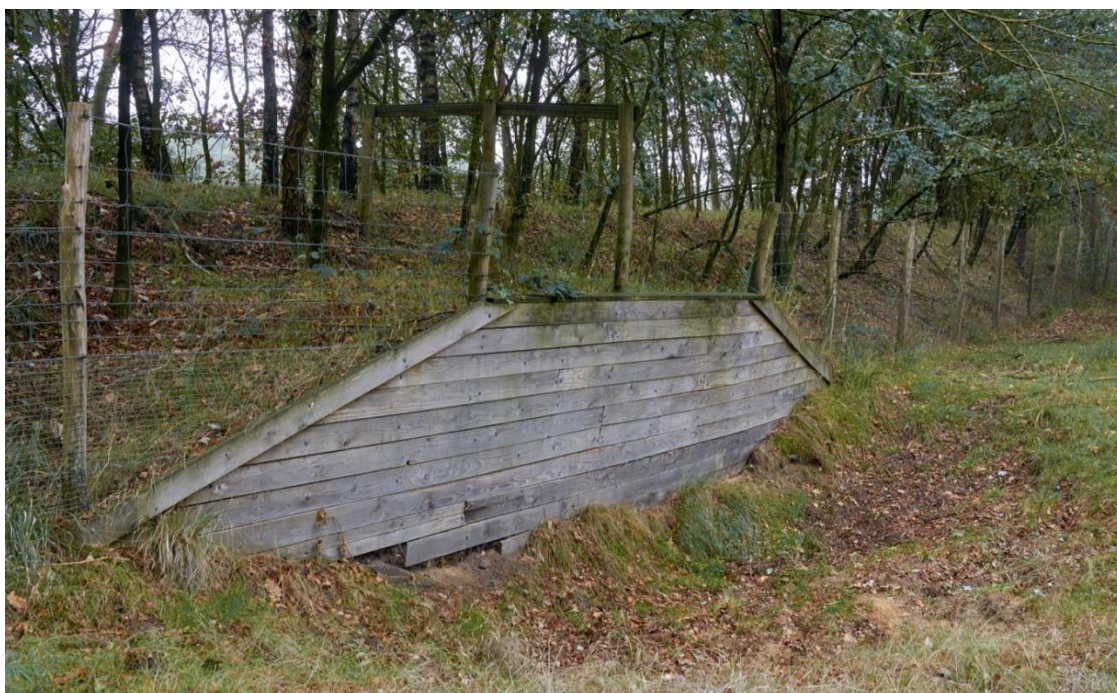
Joonis 60. Tagasihüppekoht Hollandis. Üleval on teega risti suunav aed ja on kasutatud ära teetammi laugemaks juurdepääsuks. Metsa pool on tagasihüppekoha ette kaevatud süvend, et vähendada üleshüpete tõenäosust. Foto Jaanus Remm.
