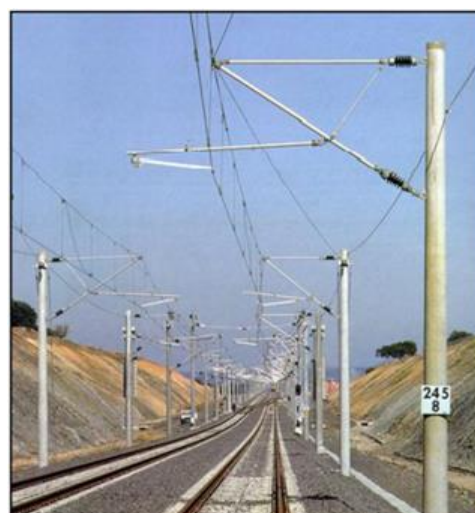
Joonis 4. Ülevaade kiirraudtee kontaktvõrgu visuaalidest. Allikas: Rail Baltica Energy Subsystem Procurement and Deployment Strategy. Final Report, 06.02.2020. Ardanuy Ingeniería, S.A., INECO
